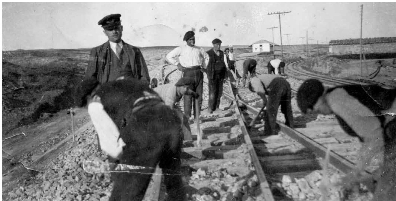
Fotografía tomada a la entrada de la Estación de María de Huerva durante la construcción de "El Caminreal", a principios de los años treinta, en la que se aprecia a la derecha el trazado de vía estrecha del ferrocarril Cariñena-Zaragoza.
