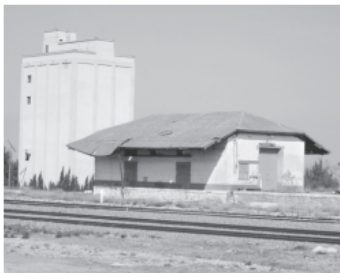
Muelle de mercancías de la estación de Cariñena
